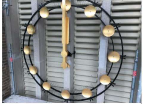
Eine der vier sanierten Turmuhren
