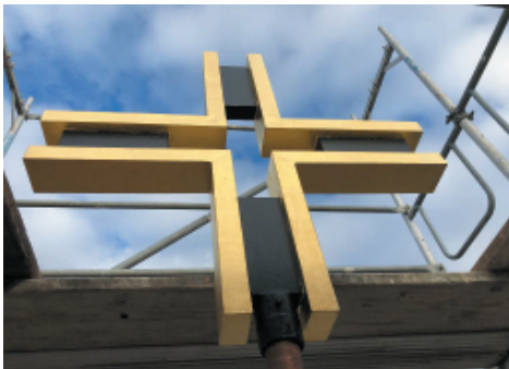
Das Kreuz auf der Spitze sanierten Kirchturm nach der neuen Vergoldung.
