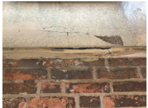
Das geschädigte Mauerwerk
