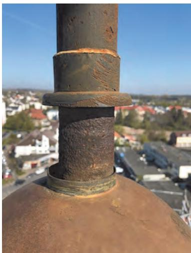
Die Kugelöffnung ist nicht mehr befestigt und Wasser kann in die Kugel eindringen.
